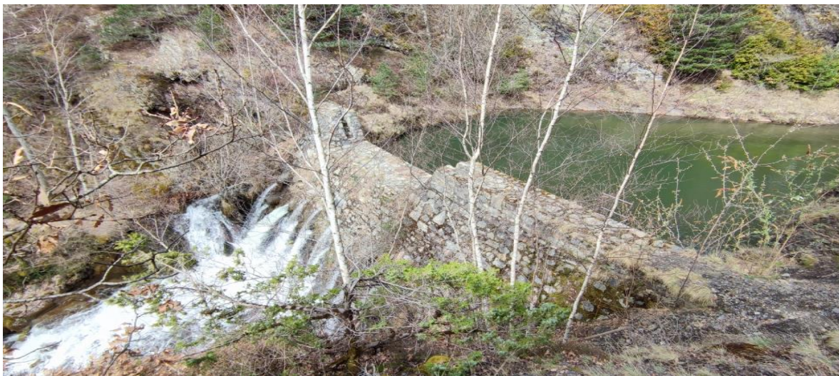
Fotografia 10. Obstacle i barrera a la continuïtat provocada per un mur de retenció de sediments. Riu d'Ós.
